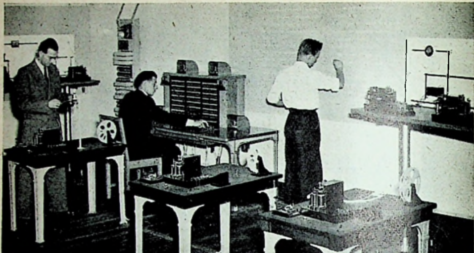
SCHAKELTECHNIEK in de afdeling seinverbindingen
